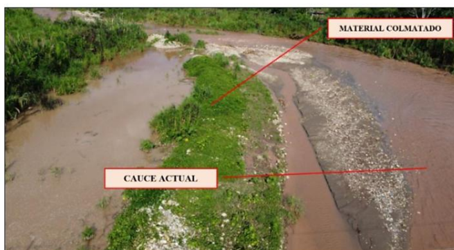
FIGURA N°02: TRAMO DEL CAUCE DEL RIO TOTALMENTE COLMATADO POR SEDIMENTOS DE ARENA Y GRAVA, QUE EN TIEMPOS DE MAXIMAS AVENIDAS ES ATENUANTE PARA EL DESBORDE DEL RIO GENERANDO INUNDACION.
